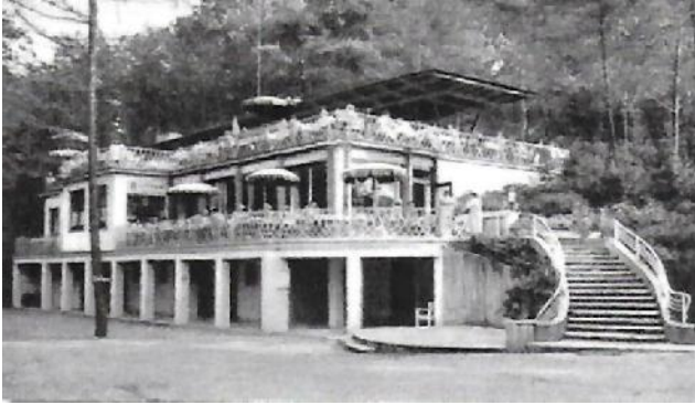
So sah es 1956 aus: die alte Gaststätte. Nur der untere Teil blieb erhalten.
